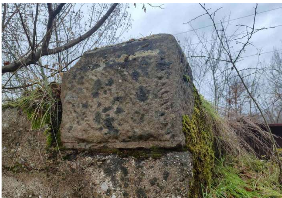
Slika 6. Nekropola Grebac, Poriječani. Stećak u gornjoj konstrukciji željezničkog mosta
