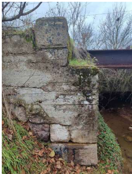
Slika 7. Nekropola Grebac, Poriječani. Stećci u konstrukciji željezničkog mosta
